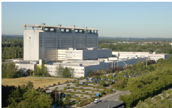
Ansicht des Universitätsklinikums München- Großhadern
